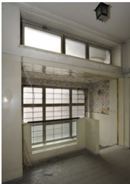
Horní „žlutá“ hala Semlerovy rezidence; stav před rekonstrukcí (2013–14; srv. fotografii stejného prostoru po restaurování na obálce této VZ)
